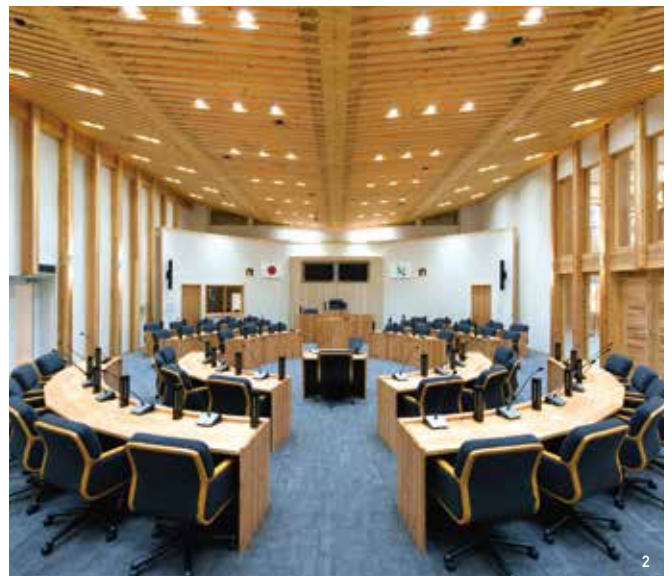
1/東館側からの外観。奥の本館はSRC構造 2/議場内。天井には張弦梁を採用し、迫力ある木の空間を形成 3/本館の格子建具を内側から見る。床はスギの圧密フローリング
